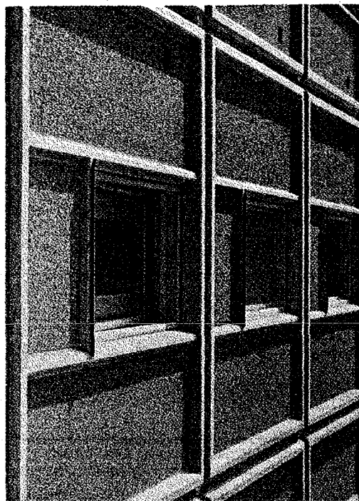
Fig. 7. Betonfacader har domineret 50'ernes montagebyggeri. Men lette facader - som benyttet i 1937, se fig. 6 - vil sikkert fortrænge de tunge betonydervægge.
